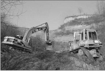
Abb. 1: Bei der Nachahmung des ökologischen Faktors Hochwasser im gepl. NSG "Frankenbacher Schotter" wird schweres Gerät eingesetzt (Foto: Wolf-Dieter Rießinger).
