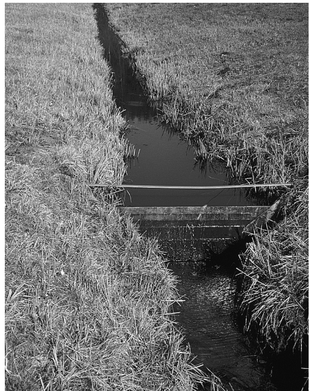
Abb. 1: Graben mit Stauwehr (nu)
