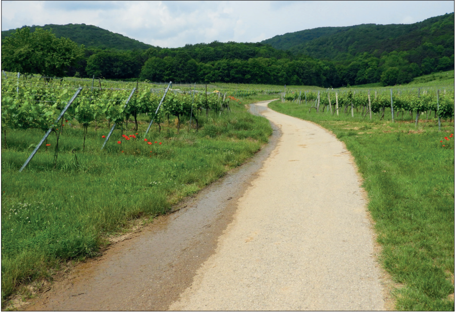
Abb. 2: Überrieselter Straßenabschnitt, Blick bergauf nach Westen in Richtung des Drainagerohres. Perchtoldsdorf (Österreich), 24.05.2018. – Foto: Andreas Chovanec.
