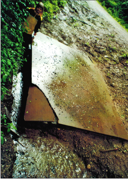
Abb. 1: Bacheinlauf in den unterirdischen Kanal ca. 100 m oberhalb des Schachtes. - Foto: Waltraud Eggs.
