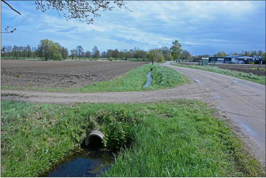
Abb. 1: Kühlwassergraben bei Dannenberg, Lüchow/Dannenberg, Niedersachsen. Im Hintergrund Abschnitt 1 mit Wasseraustritt aus unterirdischer Rohrleitung, im Vordergrund Anfang von Abschnitt 2 nach dem Durchfluss durch den Querweg. Blickrichtung nach Südost, Fließrichtung des Wassers im Bild von hinten nach vorn. 23.04.2017 – Foto E&WK.
